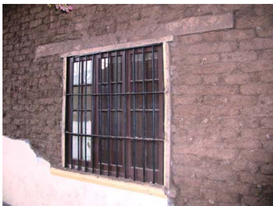
Dintel de madera sobre abertura de ventana
