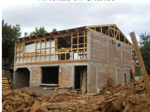
Vivienda en Quirihue
