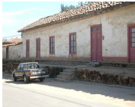
Vivienda de adobe en Paredones
