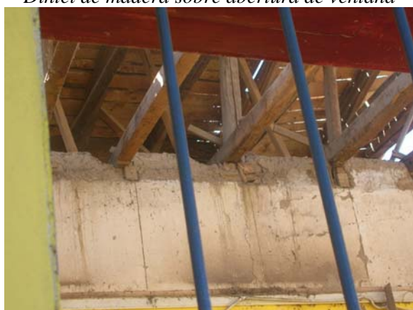
Apoyo cercha de madera sobre tabique divisorio
